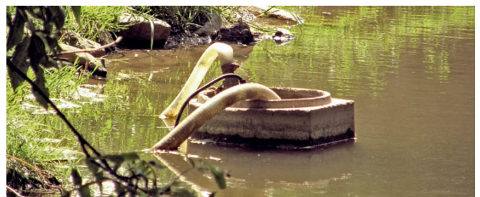
Widerrechtliche Wasserentnahme mittels Pumpe
