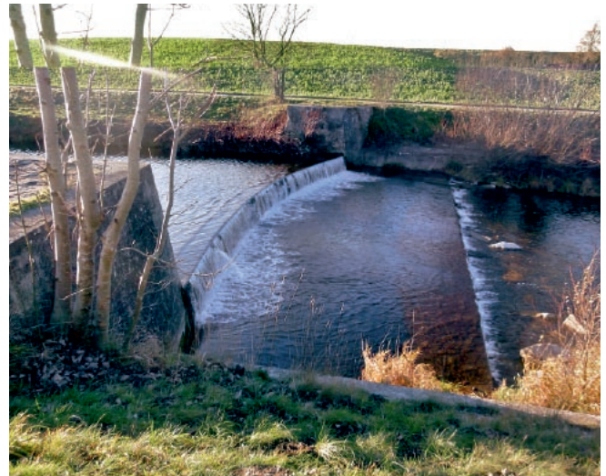
Querbauten und Begradigungen „zieren“ derzeit den Fluss.
