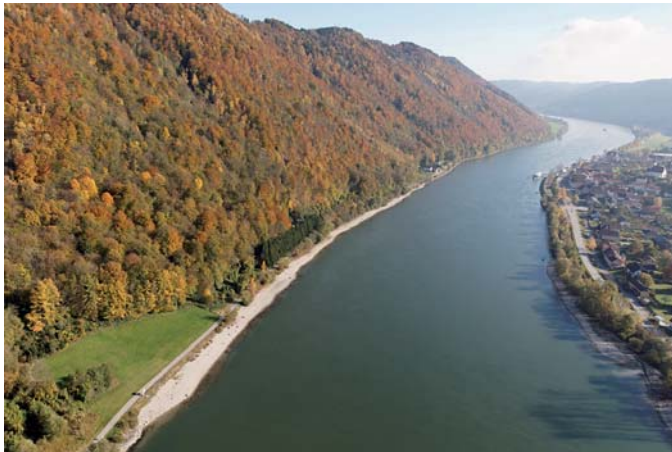
Abbildung 4: Geschüttete Kiesbänke auf beiden Ufern bei Engelhartzell
